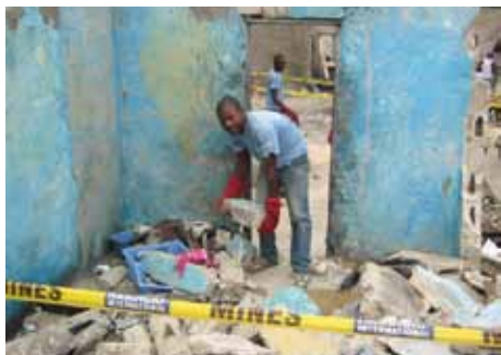
© Handicap International — Congo-Brazzaville / Déblaiement
